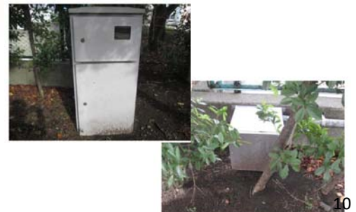
○電力設備状況（引込開閉器盤等）
