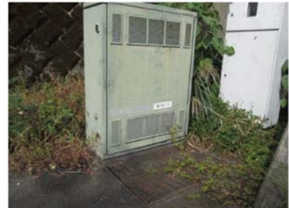
○電力設備（引込開閉器盤等）
