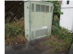
○電力設備（引込開閉器盤等）
