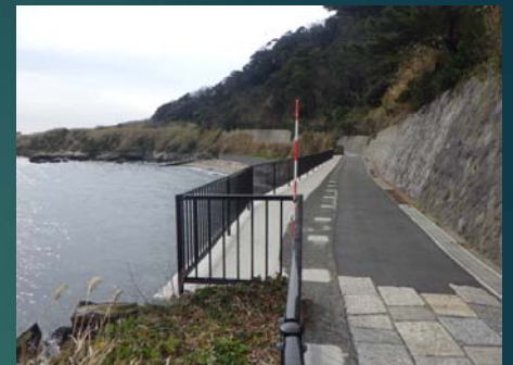
擁壁上部の状況
