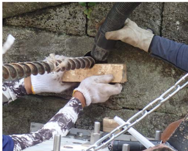
削孔状況 周辺が汚れないようにスライム をバキュームで回収
