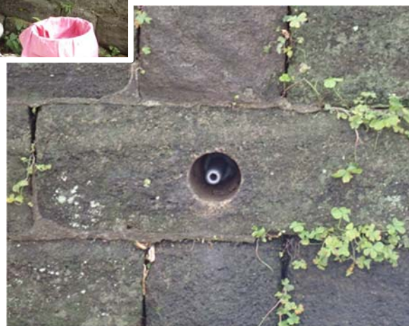
補強材挿入後
