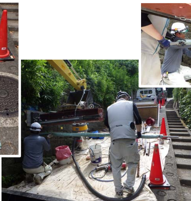
補強材挿入
