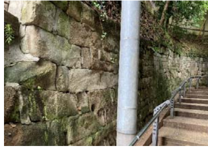
(b)変状後の修復の様子
