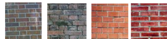
(a)フランス積 (b)イギリス積 (c)ドイツ積 (d)長手積
