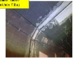
③漏水（湧水） 2ml/min 「Ea」
