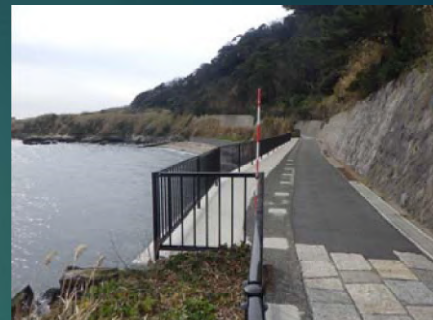
擁壁上部の状況
