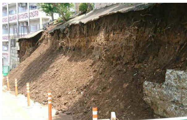
(b)崩壊後の様子
