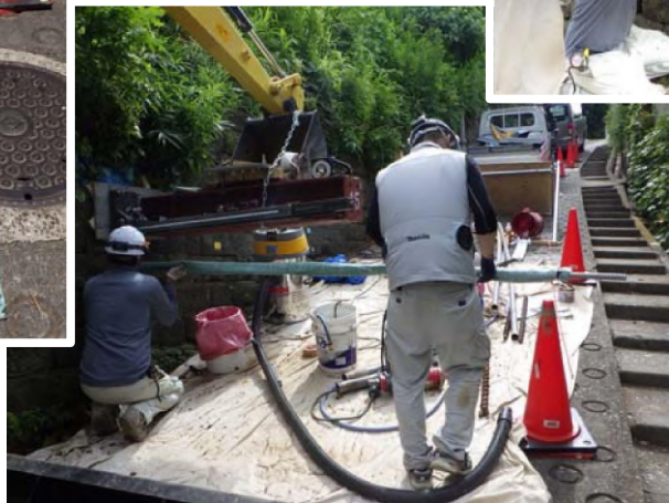
補強材挿入
