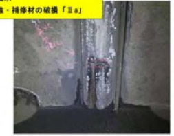
③漏水（湧水） 2ml/min 「Ea」
