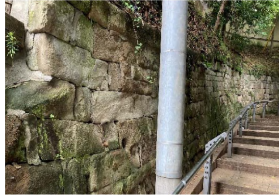
(b)変状後の修復の様子
