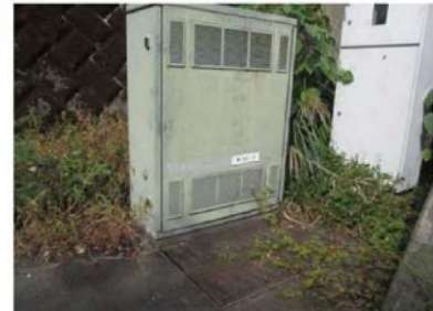
○電力設備（引込開閉器盤等）
