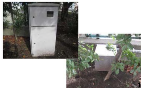
○電力設備状況(引込開閉器盤等)
