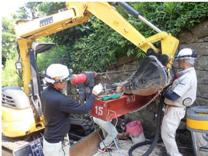
削孔状況 夜間通行止め解除するため 連続足場が組めない
