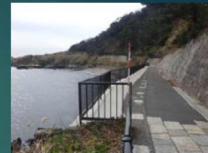
擁壁上部の状況
