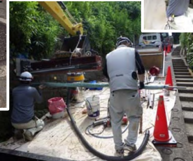
補強材挿入
