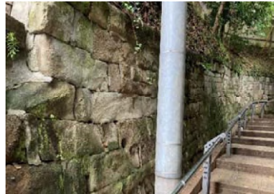
(b)変状後の修復の様子
