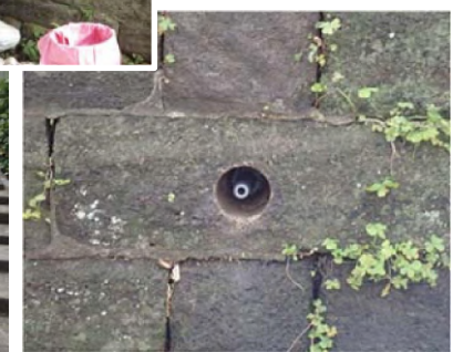
補強材挿入後
