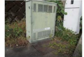
○電力設備 (引込開閉器盤等)
